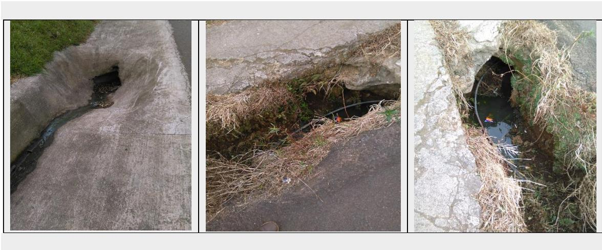
De acuerdo con la información recibida, los trabajos efectuados por esta Municipalidad encauzaron el agua pluvial sin las precauciones para evitar la inundación de la carretera en la época lluviosa, con la afectación que esto les está causando.
