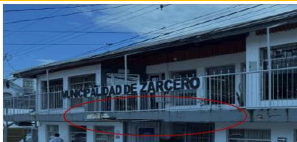
Esta fotografía que nos revela un problema constructivo que se presentó en el edificio que era el desprendimiento de parte del cielo raso. Vemos aquí en la entrada principal, en la parte superior, en la parte inferior, que podría ocasionar una lesión a un transeúnte o a un ciudadano o a un funcionario.
