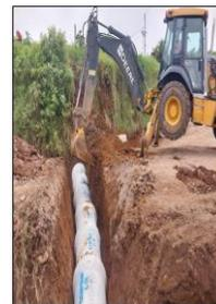
Qué es básicamente limpieza, mecanizadas, colocación y compactación de material, acarreo, limpieza y conformación de material, colocación de alcantarillas, construcción de cajas de registro demarcaciones, entre otras funciones, las cuales se realizan en diferentes localidades del cantón y como lo dice don Ronald, obviamente es necesaria la maquinaria, pero es mucho el trabajo, algunos
