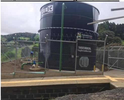
Proyecto de construcción de Tanque de Acero Vitrificado Virgilio Gamboa, el proyecto consistió en la construcción de un Tanque de almacenamiento de agua para el abastecimiento de este recurso para la parte central de Zarceró.
